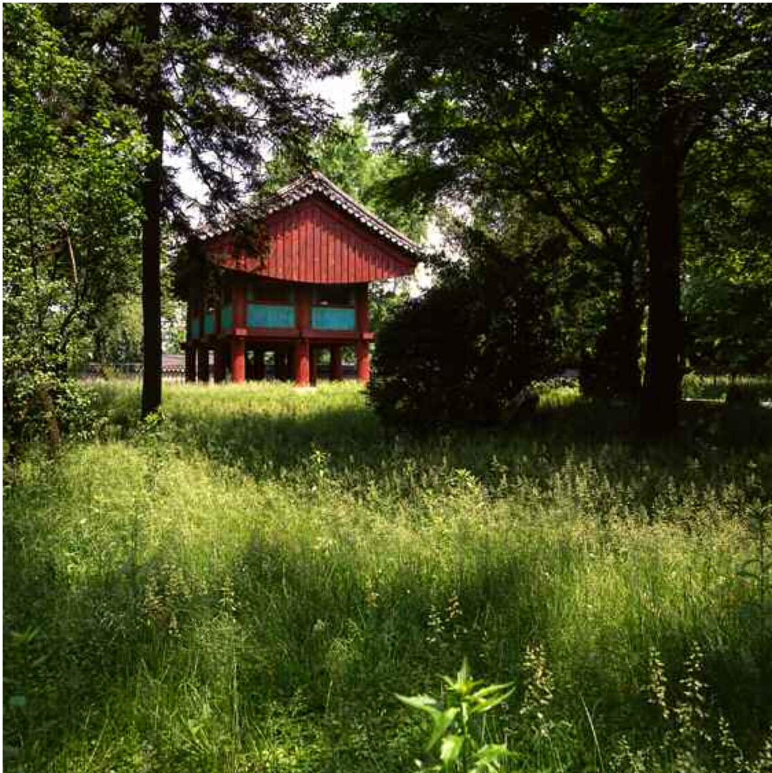
25. Petit pavillon sur pilotis.
